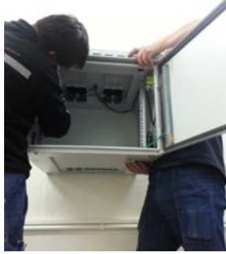
Kabinetin duvara montajı
