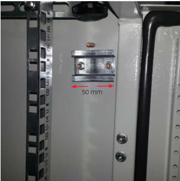
Termostat modülü montaj rayı (kabinetin ön sağ üst köşesinde)
