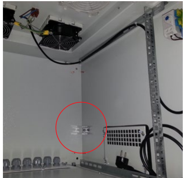
Pano ısıtıcı montaj rayı (kabinetin arka sağ alt köşesinde)
